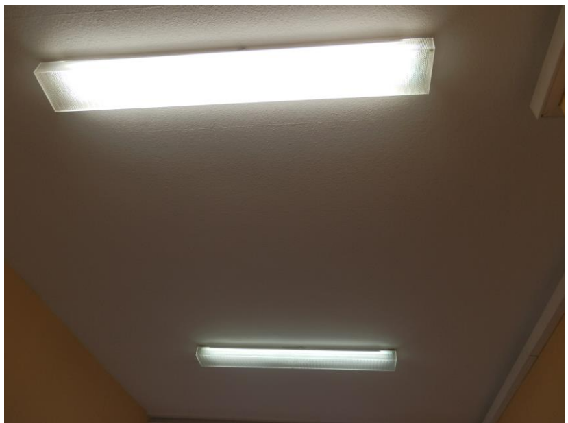
Foto: Toilette EG, alte Beleuchtung
