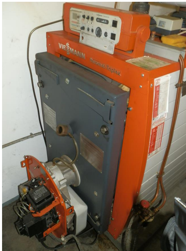
Foto: Niedertemperaturkessel
