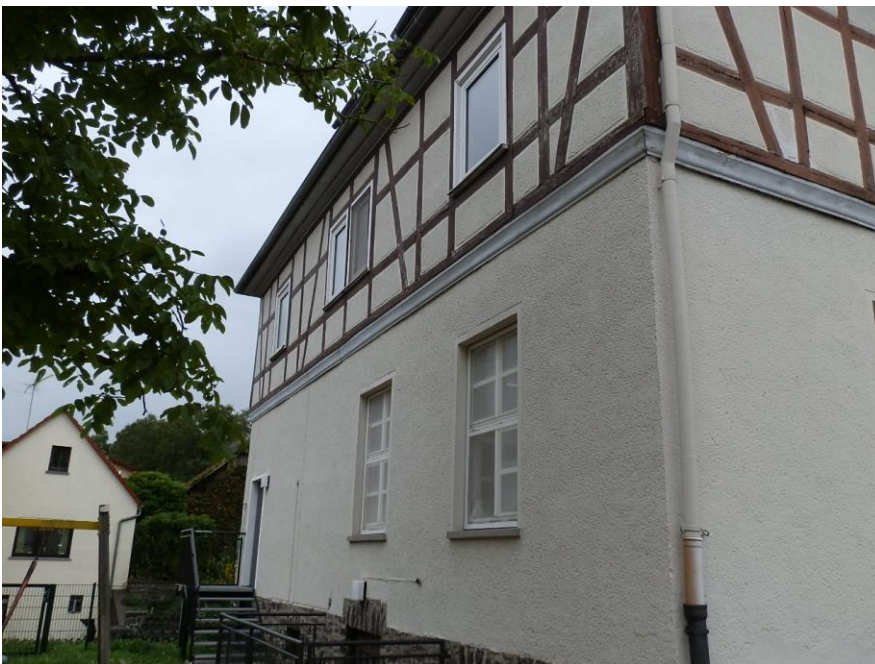
Foto: Fassade/Ansicht Süd-Ost
