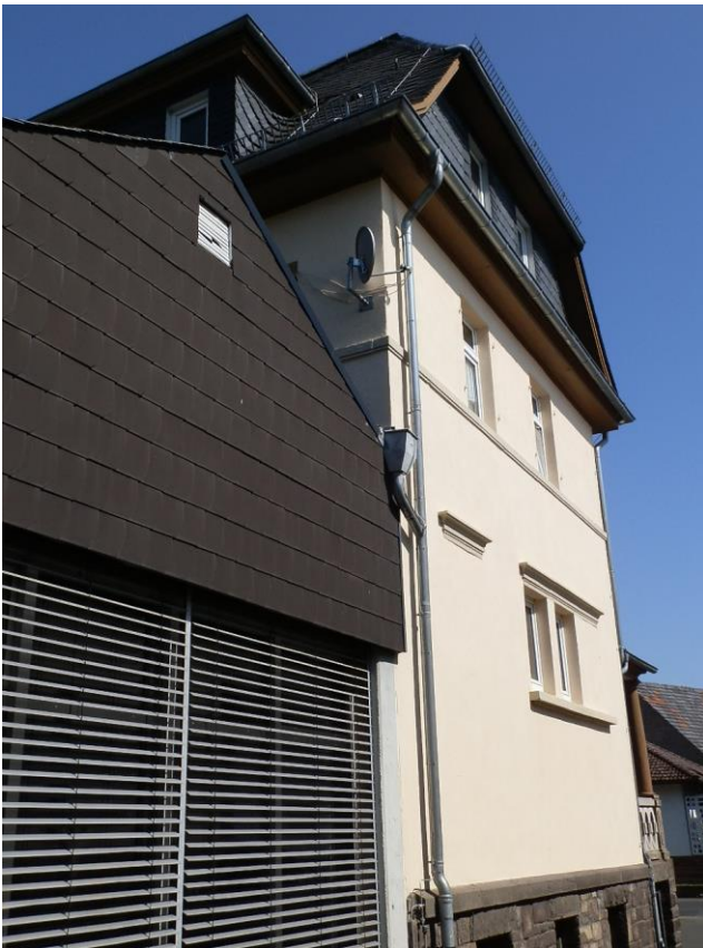
Foto: Altbau/Fassade, verputzt
