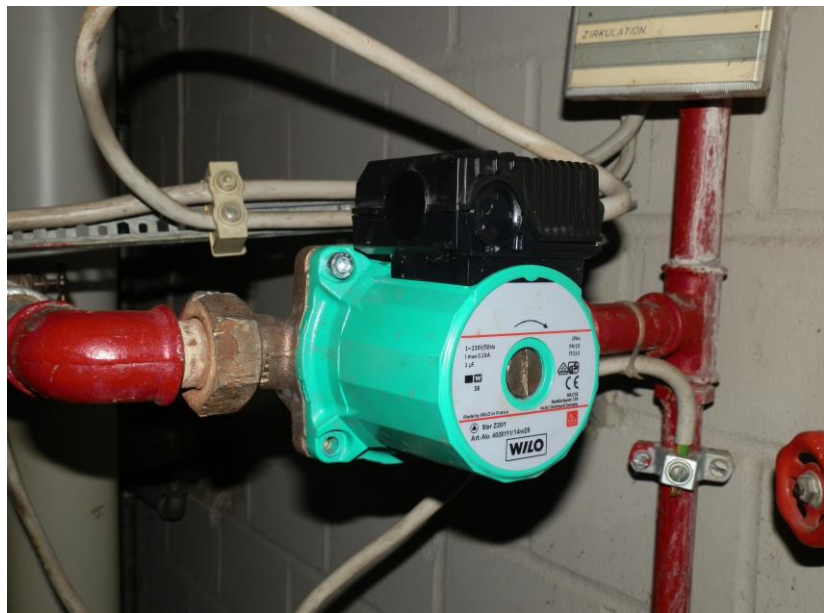
Foto: Zirkulationspumpe
