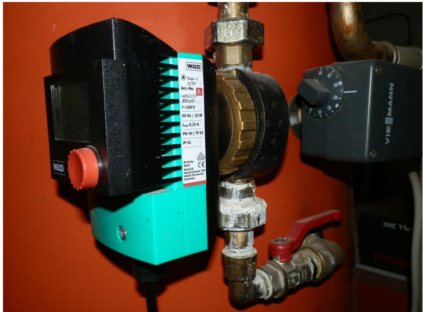
Foto: Zirkulationspumpe
