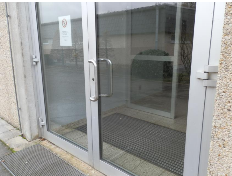
Foto: Tür, neue Isolierverglasung
