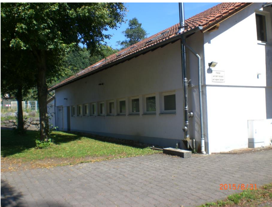
Foto: Fassade/Ansicht West
