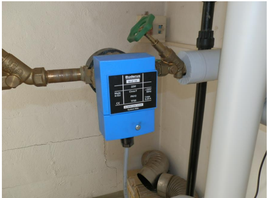
Foto: Zirkulationspumpe
