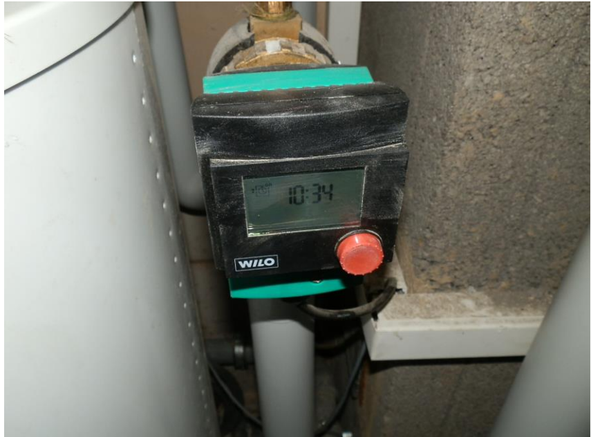
Foto: Zirkulationspumpe
