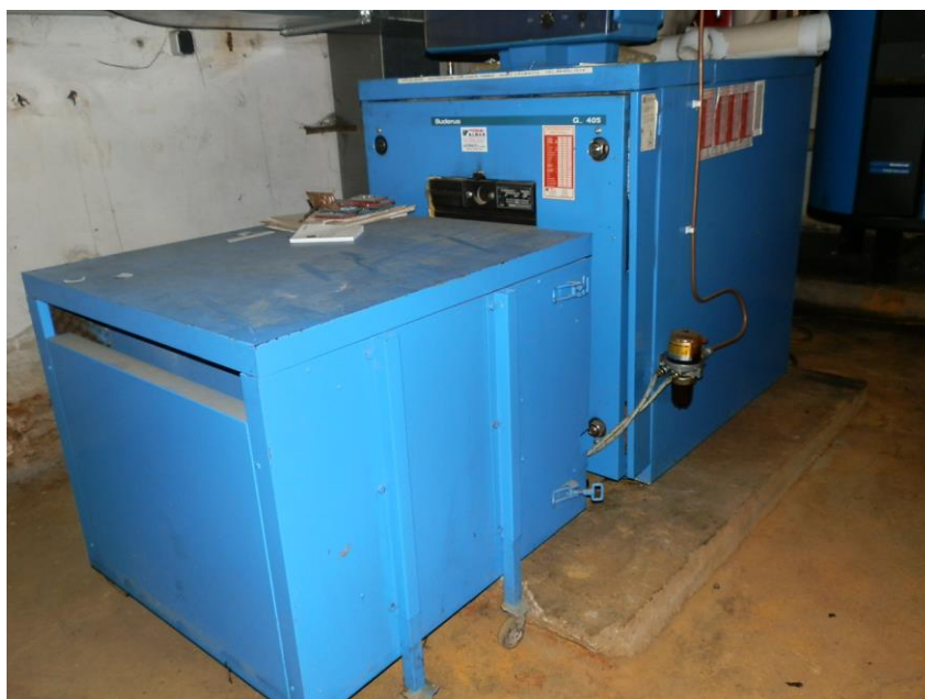
Foto: Niedertemperatur-Kessel
