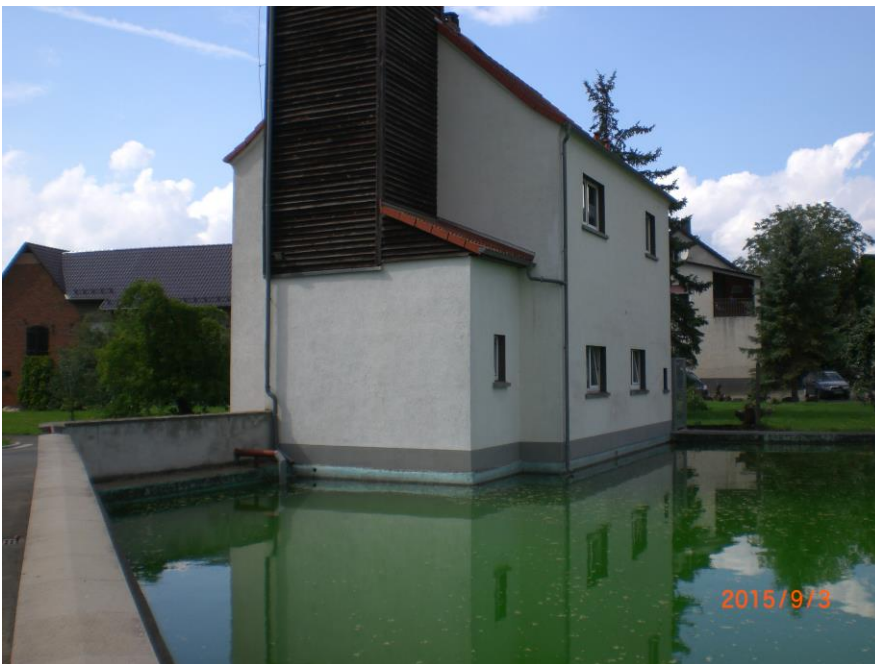
Foto: Fassade/Ansicht Süd-Ost und Nord-Ost
