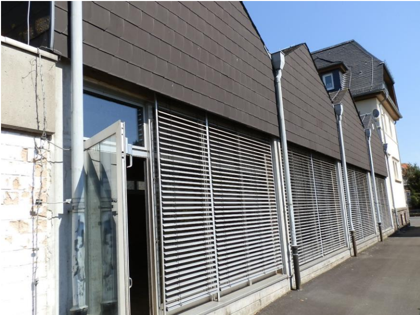
Foto: Anbau – Saal/Fassade mit Kunststoffschieferplatten
