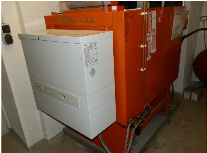
Foto: Niedertemperaturkessel
