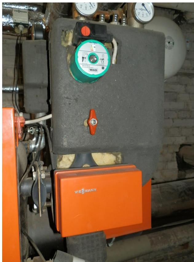
Foto: Heizungsumwälzpumpe
