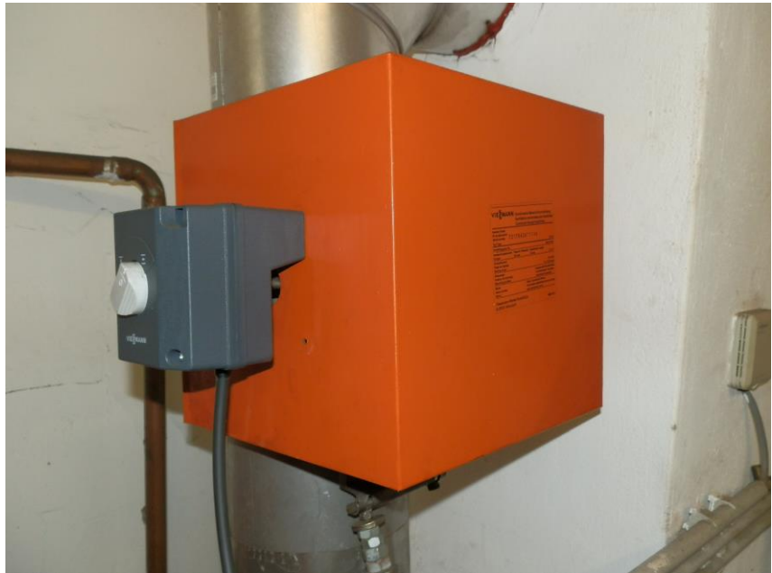
Foto: motorische Abgasklappe
