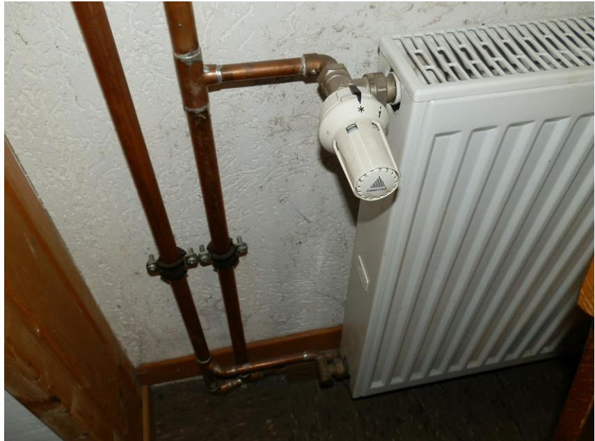
Foto: Heizkörper mit voreinstellbarem Thermostatventil
