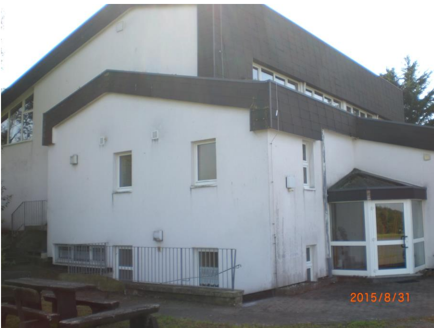
Foto: Fassade/Ansicht Nord
