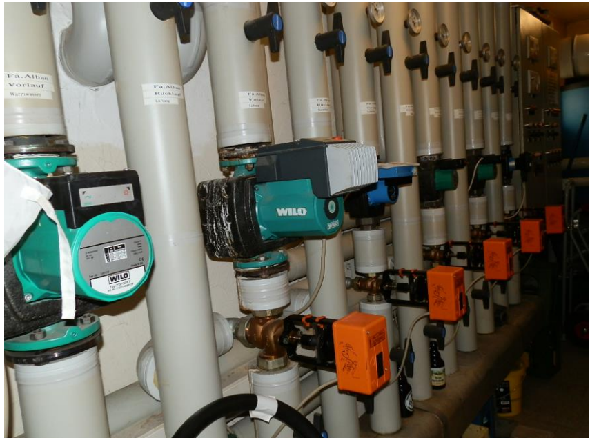
Foto: Umwälzpumpen/Verteiler
