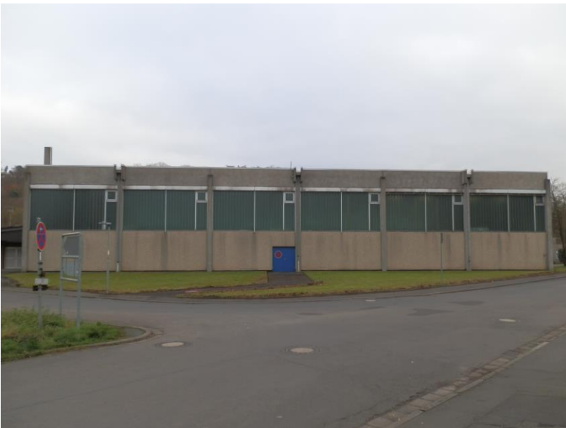
Foto: Fassade, Ansicht West
