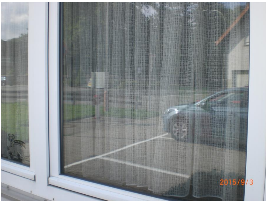
Foto: alte Isolierverglasung
