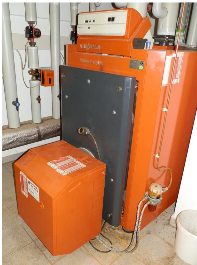
Foto: Niedertemperaturkessel
