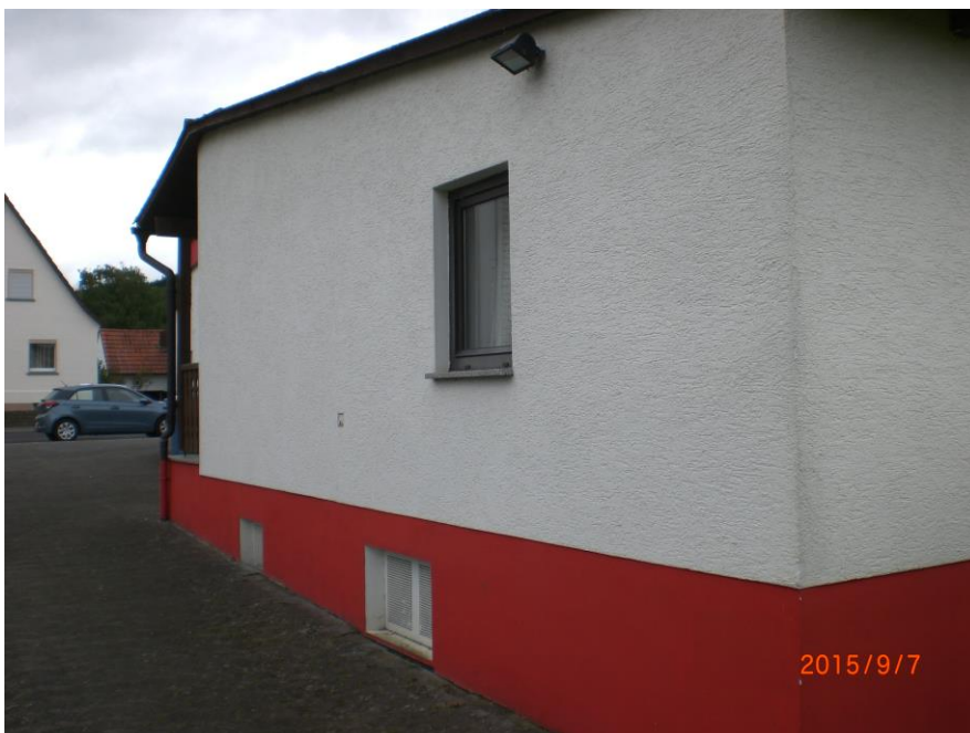
Foto: Fassade/Ansicht Nord
