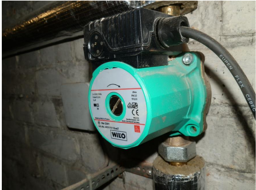
Foto: Zirkulationspumpe
