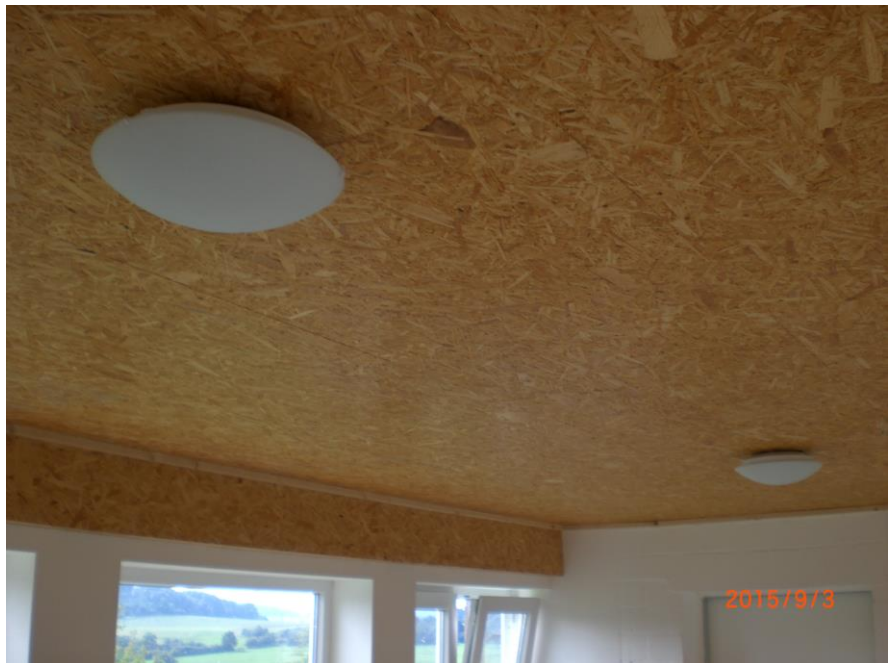
Foto: sanierte Beleuchtungsanlage
