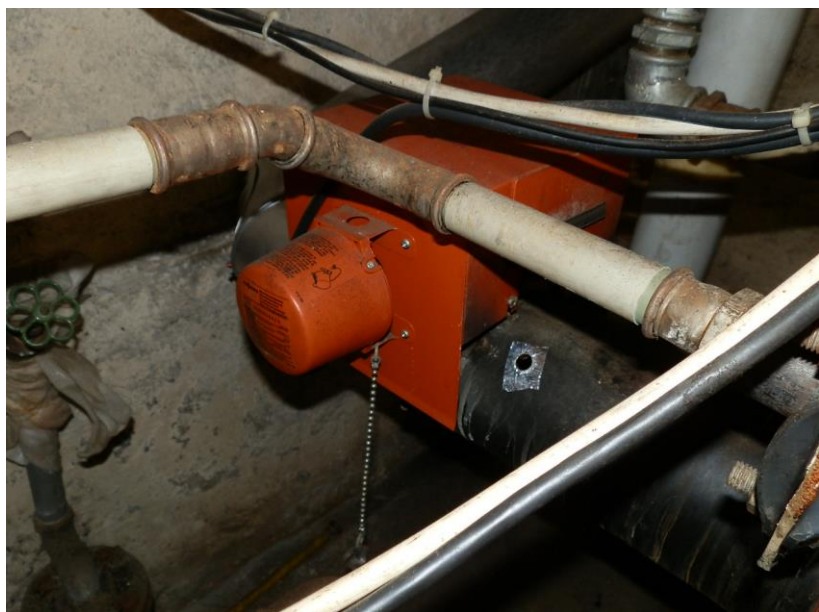
Foto: Motorische Abgasklappe
