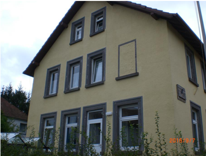
Foto: Fassade/Ansicht Nord-Ost
