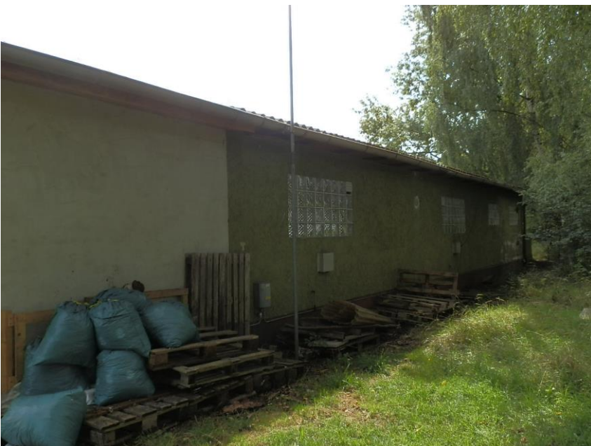
Foto: Fassade/Ansicht West
