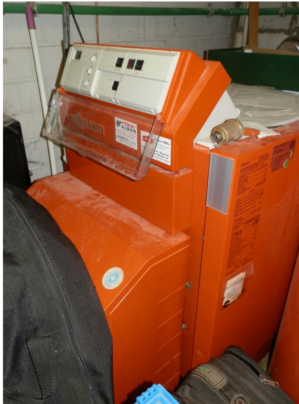
Foto: Niedertemperaturkessel
