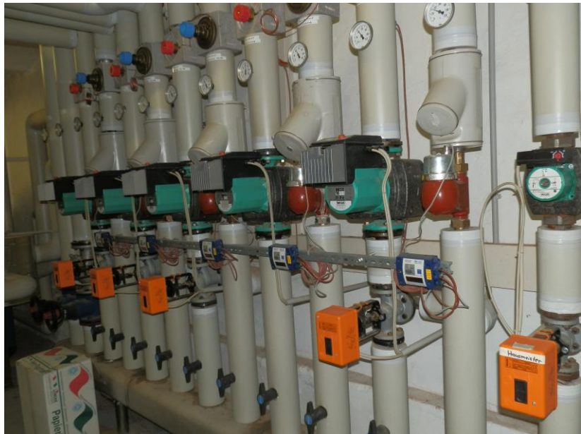
Foto: Umwälzpumpen/Verteiler
