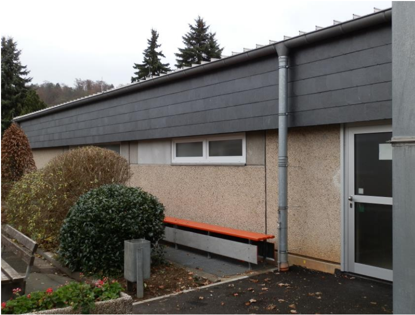
Foto: Fassade, Ansicht West
