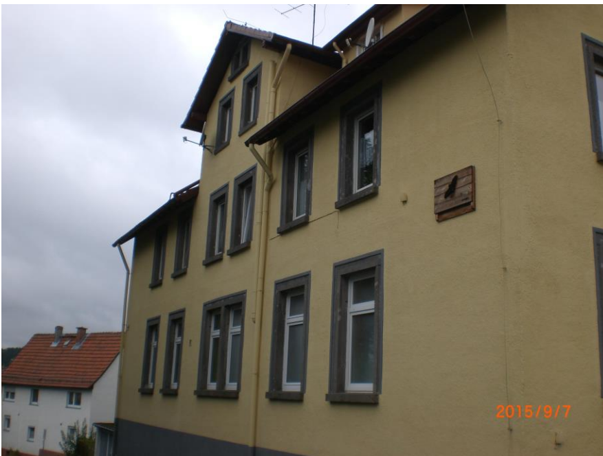
Foto: Fassade/Ansicht Süd-Ost
