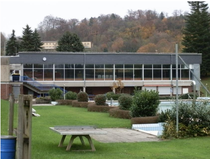
Foto: Fassade, Ansicht Süd
