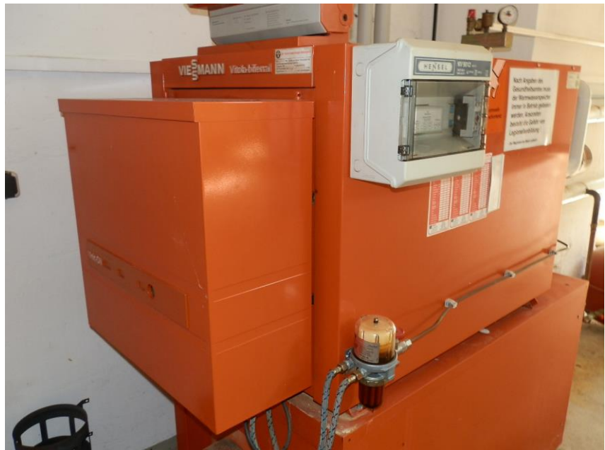
Foto: Niedertemperaturkessel
