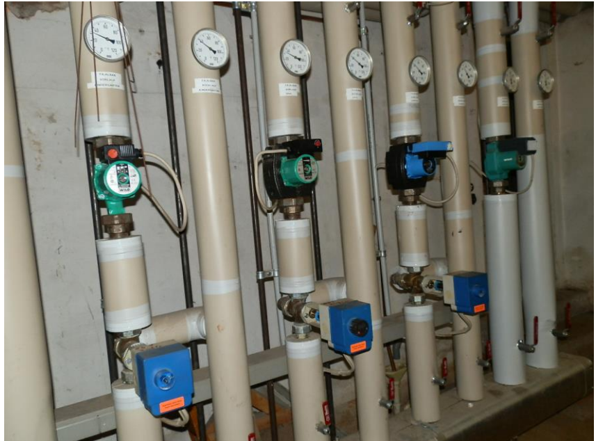
Foto: Umwälzpumpen/Verteiler
