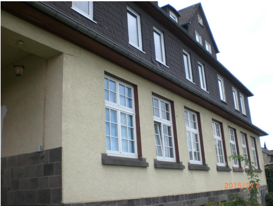
Foto: Fassade/Ansicht Süd-Ost
