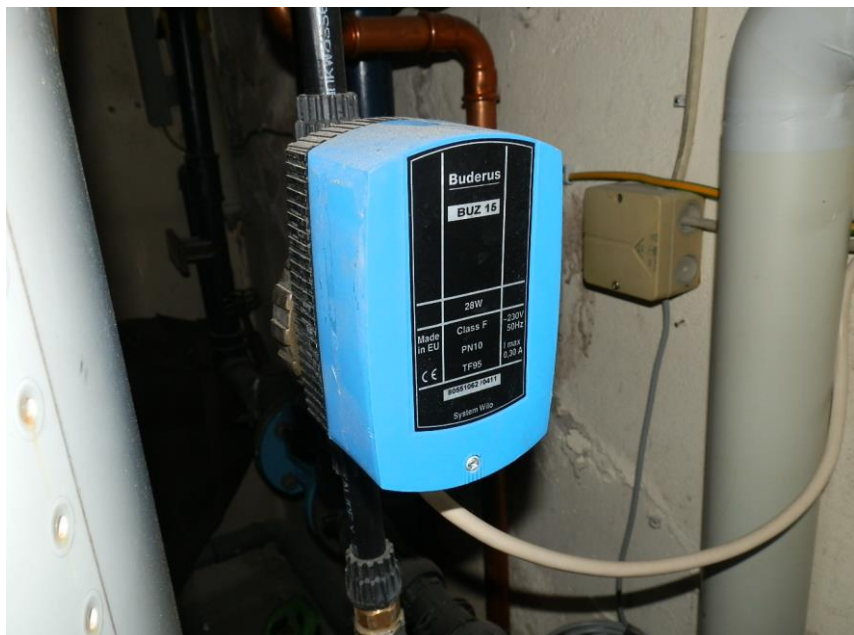
Foto: Zirkulationspumpe
