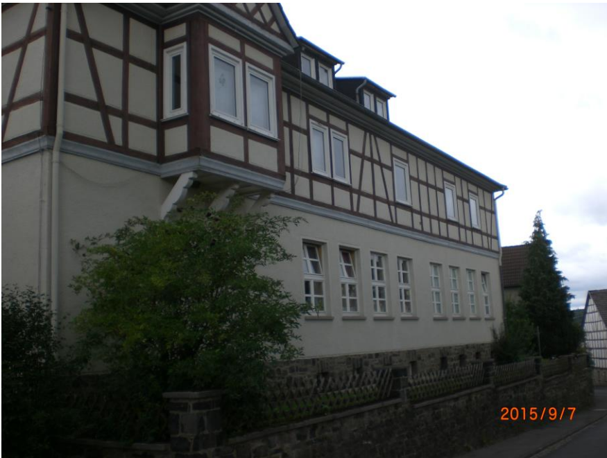
Foto: Fassade/Ansicht Nord-Ost
