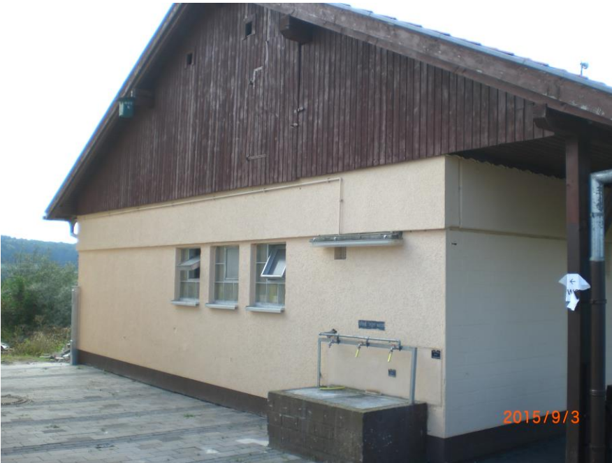
Foto: Fassade/Ansicht Nord-Ost
