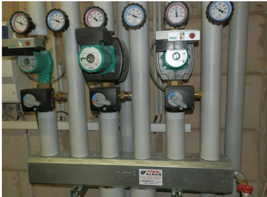
Foto: Umwälzpumpen/Verteiler
