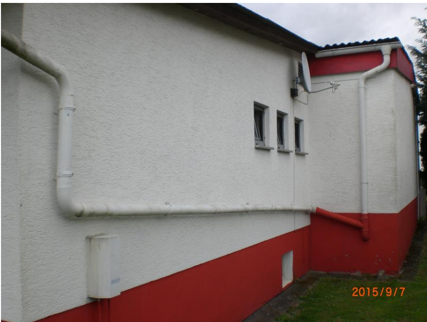
Foto: Fassade/Ansicht Süd
