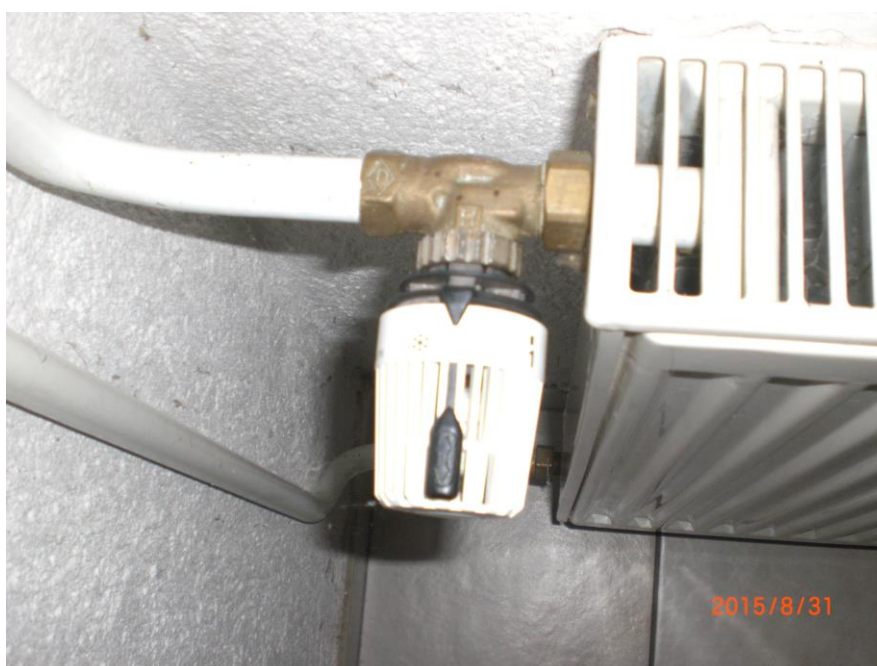
Foto: Thermostatventil
