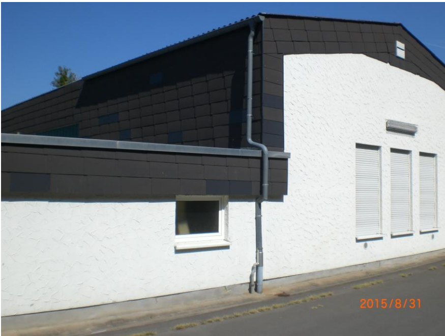
Foto: Fassade/Ansicht Süd
