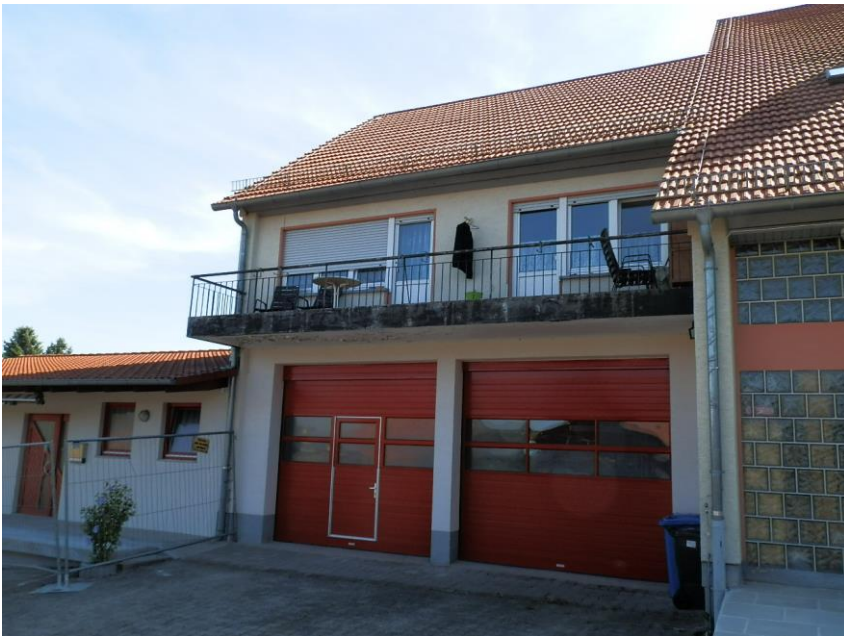
Foto: Fassade/Ansicht West
