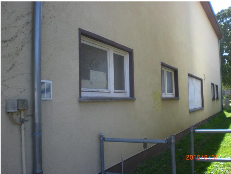
Foto: Fassade/Ansicht West
