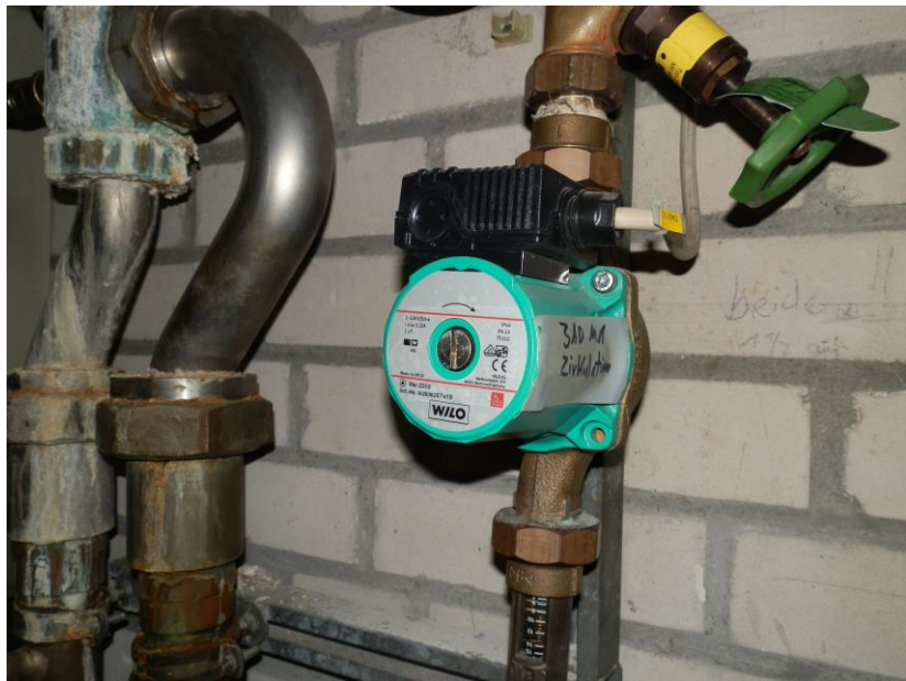
Foto: Zirkulationspumpe
