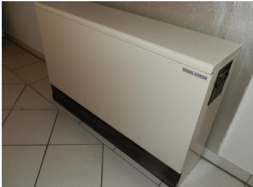
Foto: Wärmespeicherheizkörper
