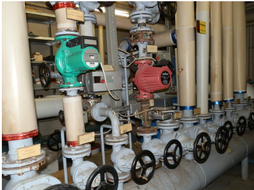
Foto: Umwälzpumpen/Heizungsverteiler
