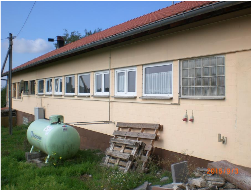
Foto: Fassade/Ansicht Süd-Ost
