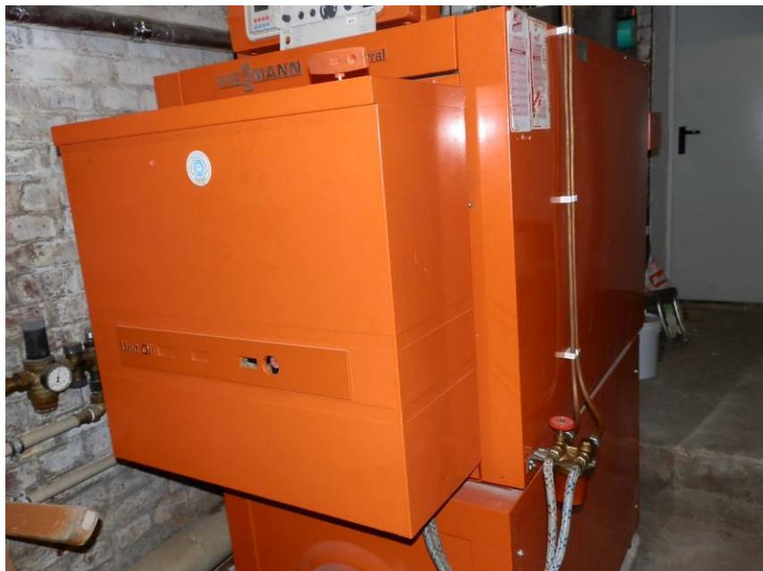
Foto: Niedertemperaturkessel
