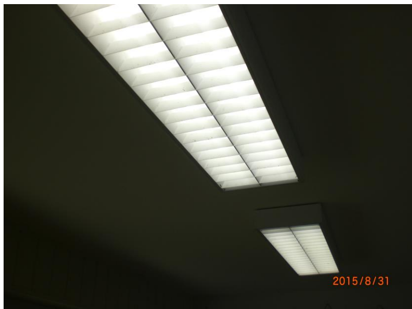
Foto: veraltete Beleuchtung Umkleide
