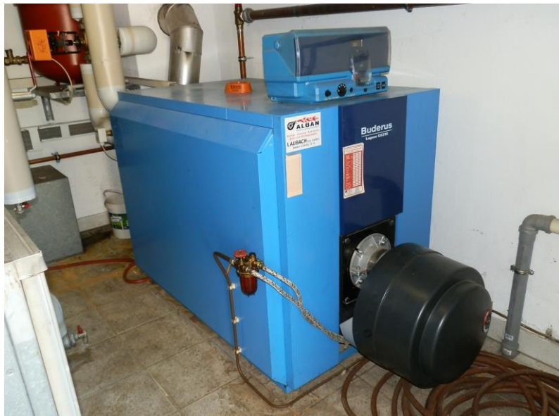
Foto: Niedertemperaturkessel
