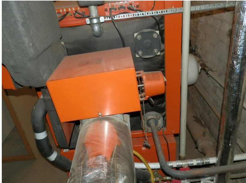
Foto: motorische Abgasklappe
