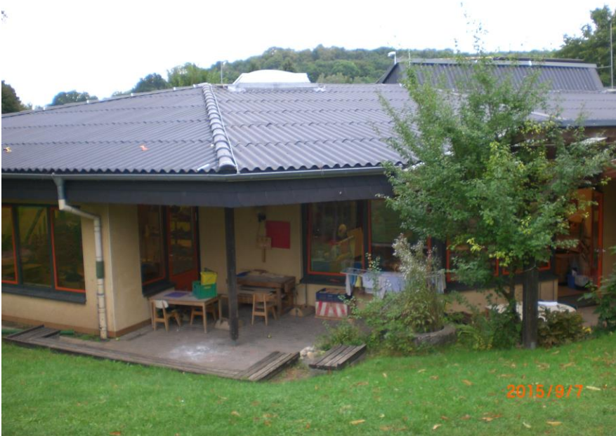
Foto: Fassade/Ansicht Rückseite
