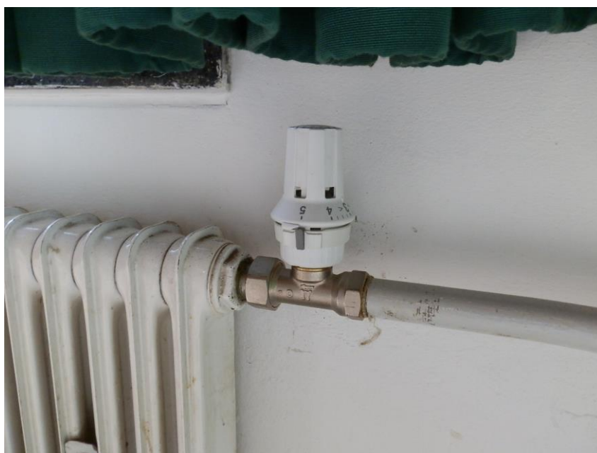
Foto: Heizkörper mit voreinstellbarem Thermostatventil
