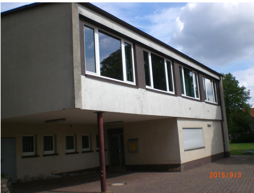
Foto: Fassade/Ansicht Süd
