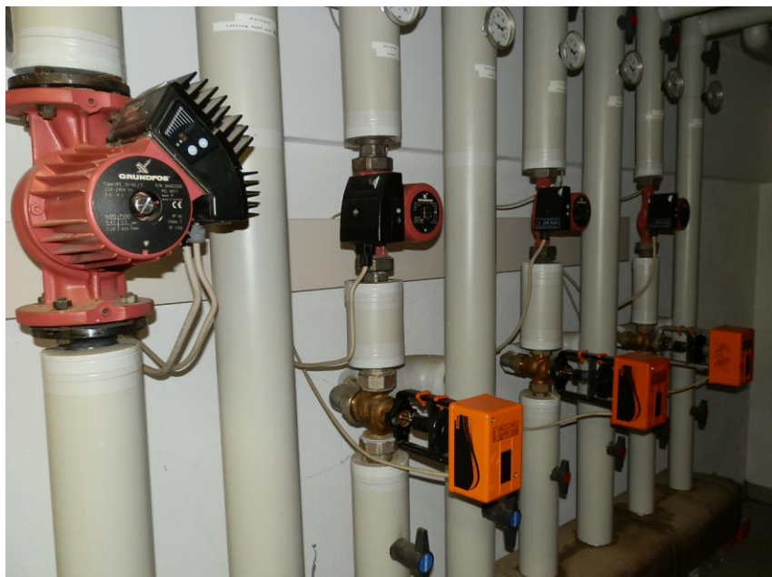
Foto: Umwälzpumpen/Verteiler
