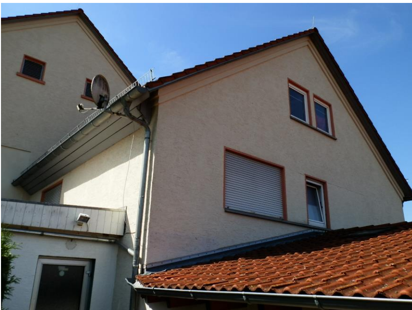
Foto: Fassade/Ansicht Nord
