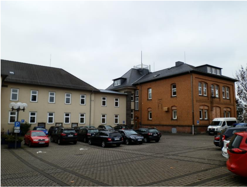
Foto: Fassade, Ansicht Nord-Ost
