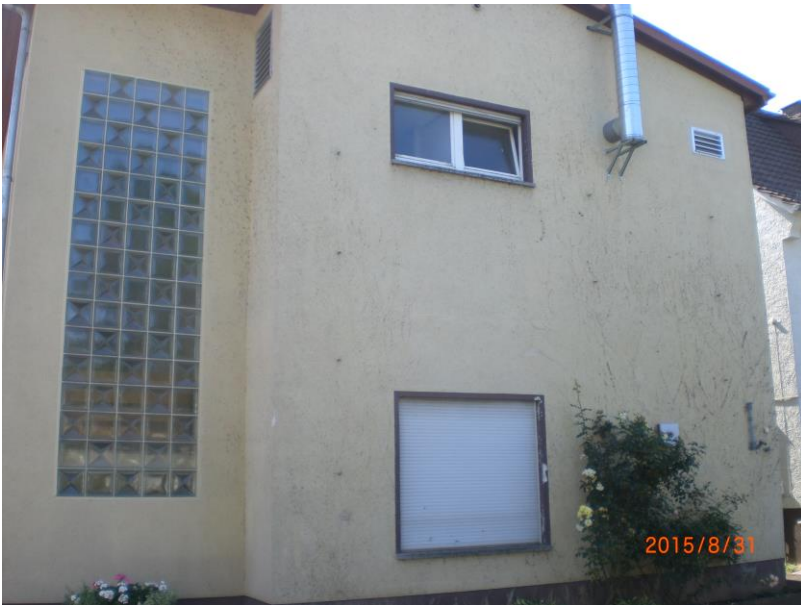
Foto: Fassade/Ansicht Nord
