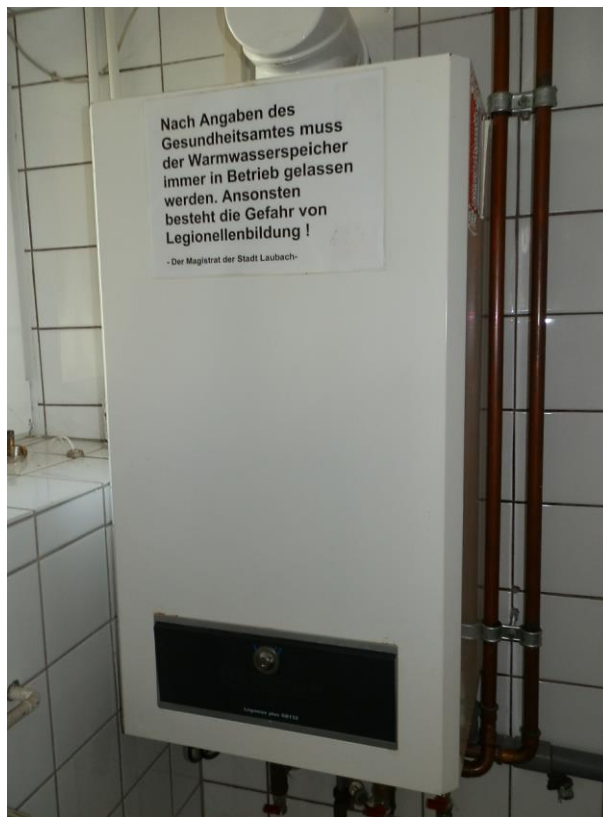
Foto: Brennwertgerät
