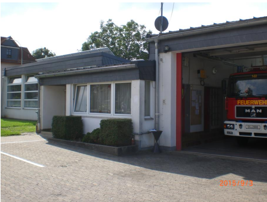
Foto: Fassade/Ansicht Nord
