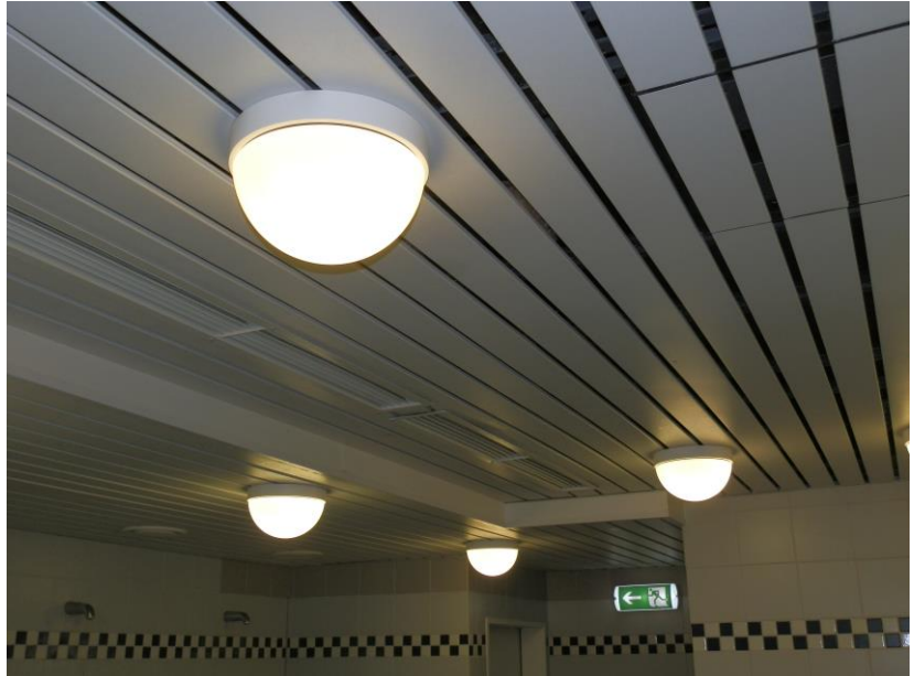
Foto: Duschraum mit neuer Beleuchtung
