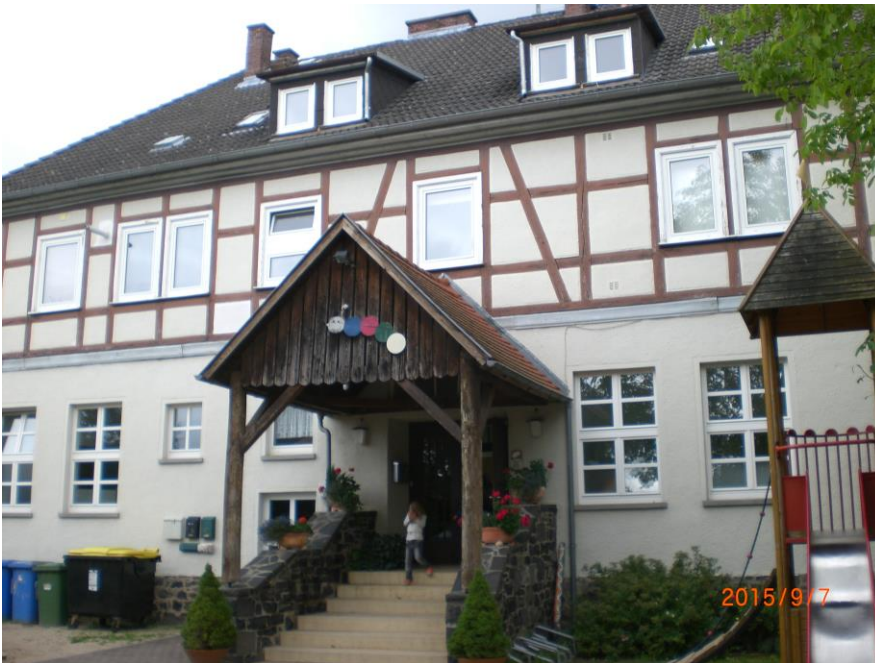
Foto: Fassade/Ansicht Süd-West
