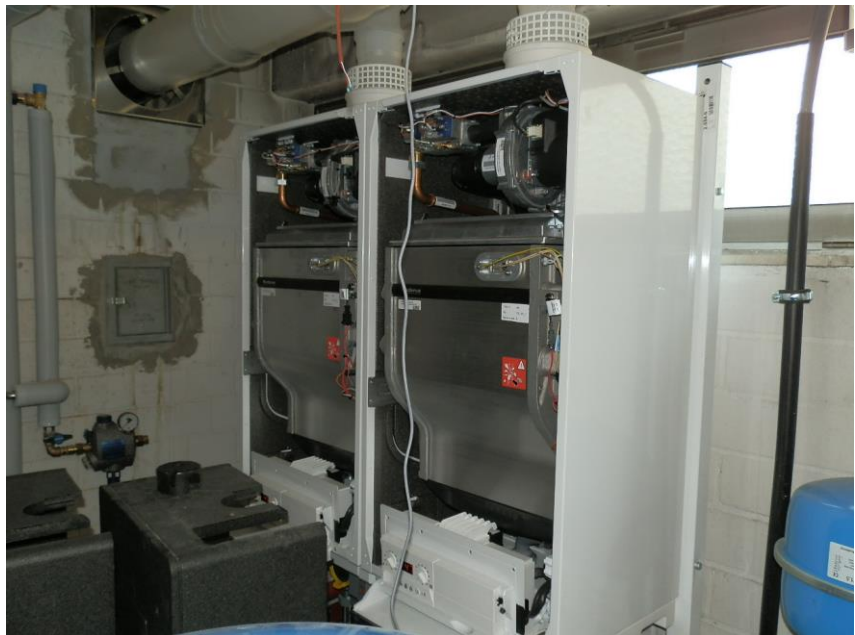
Foto: neue Brennwertgeräte
