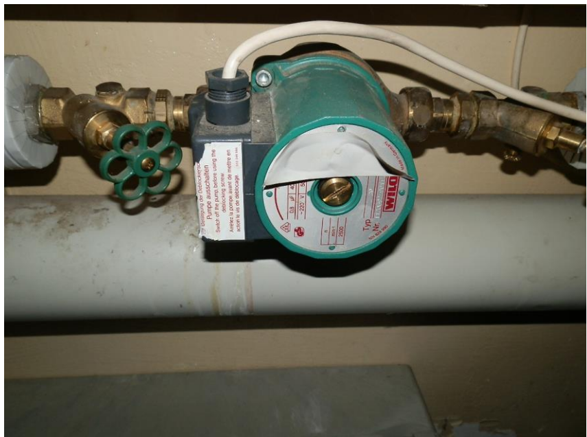
Foto: Zirkulationspumpe
