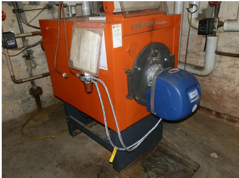
Foto: Niedertemperaturkessel
