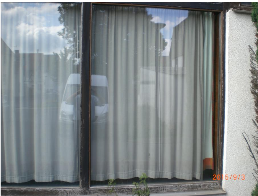
Foto: Saal, alte Fenster
