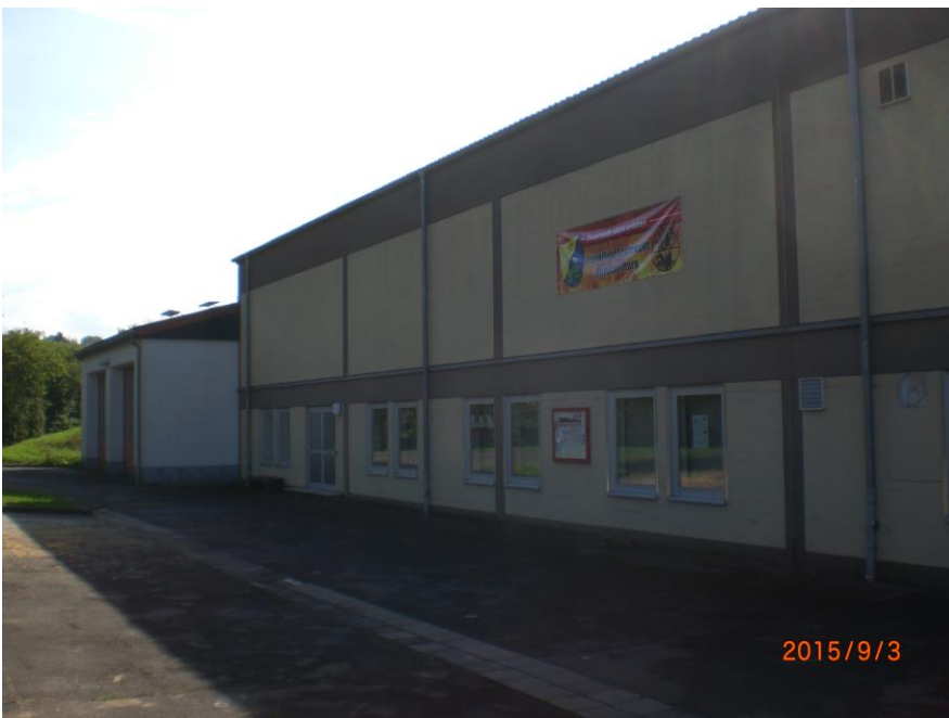
Foto: Fassade/Ansicht Nord
