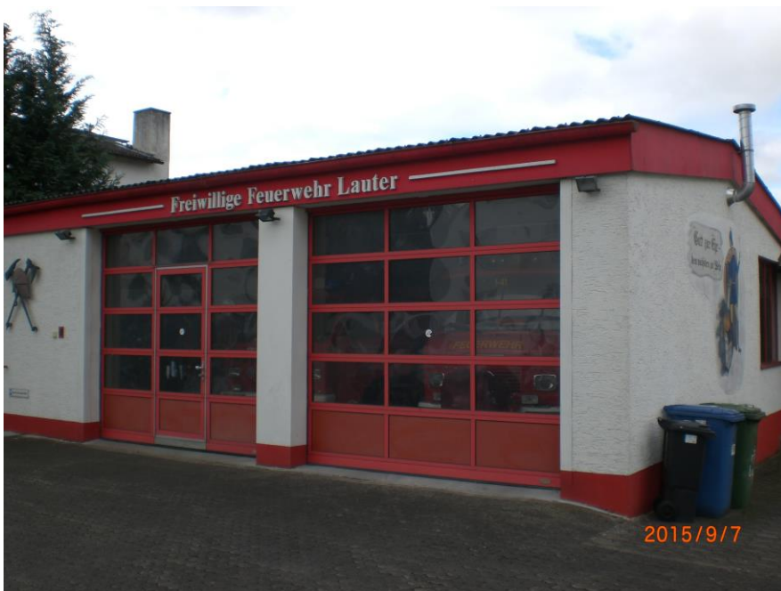
Foto: Fassade/Ansicht Ost und Nord
