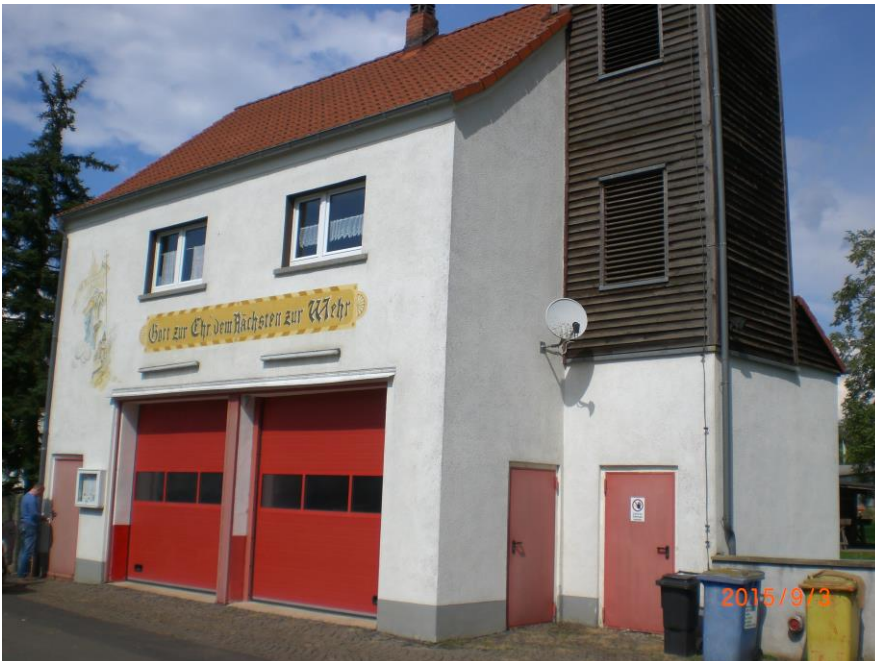
Foto: Fassade/Ansicht Süd-West
