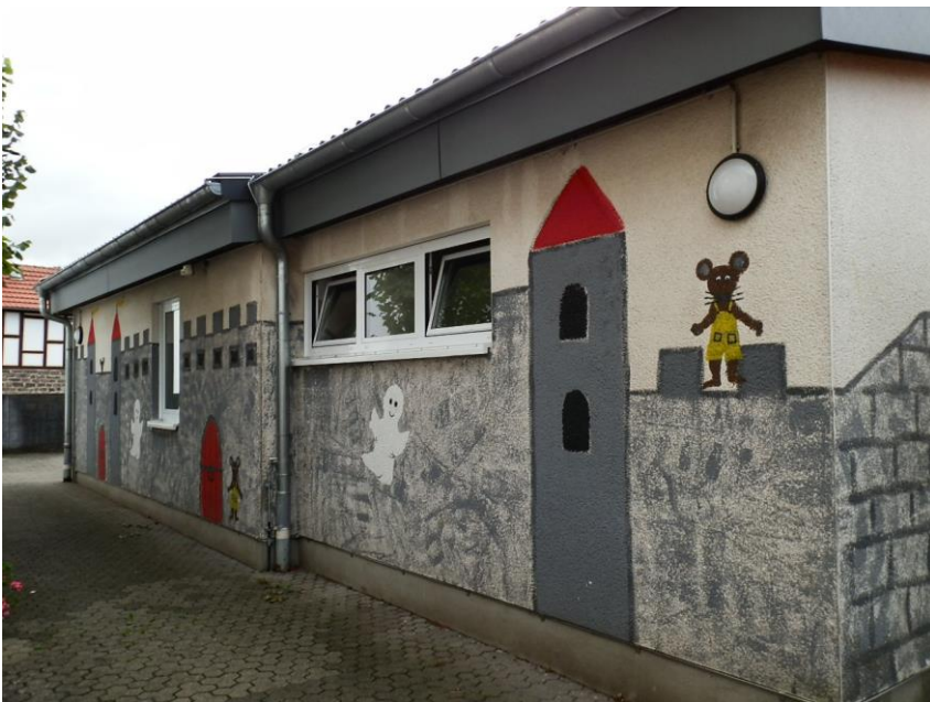
Foto: Fassade/Ansicht Nord
