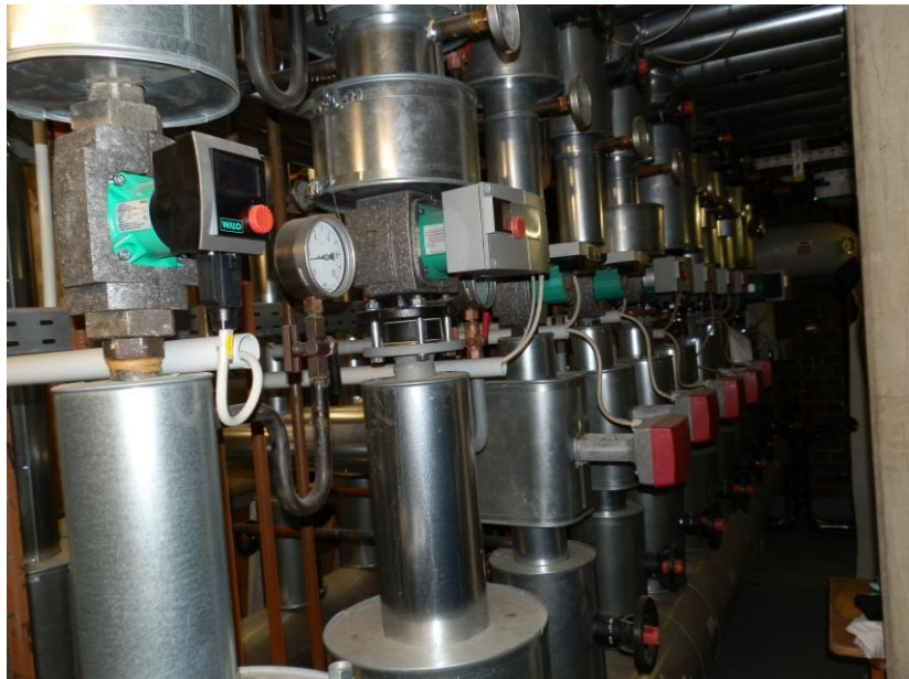
Foto: Heizungsverteiler/Hocheffizienzpumpen
