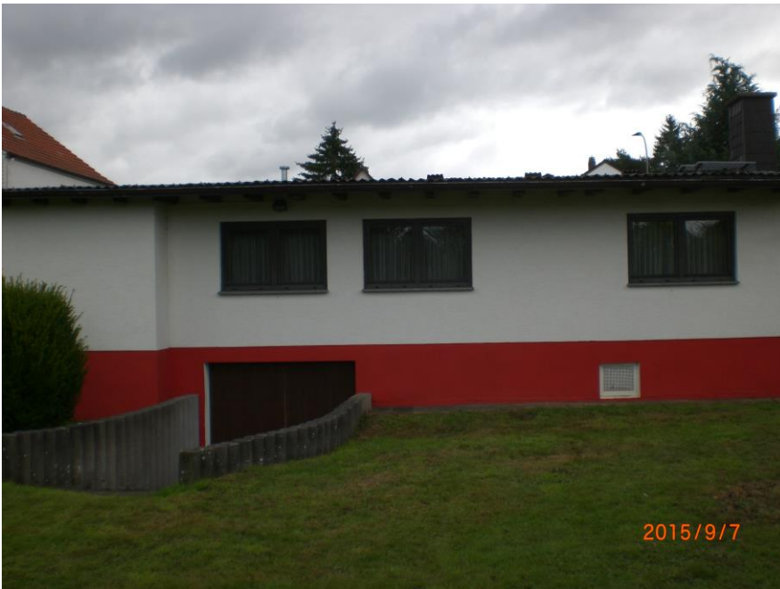
Foto: Fassade/Ansicht West
