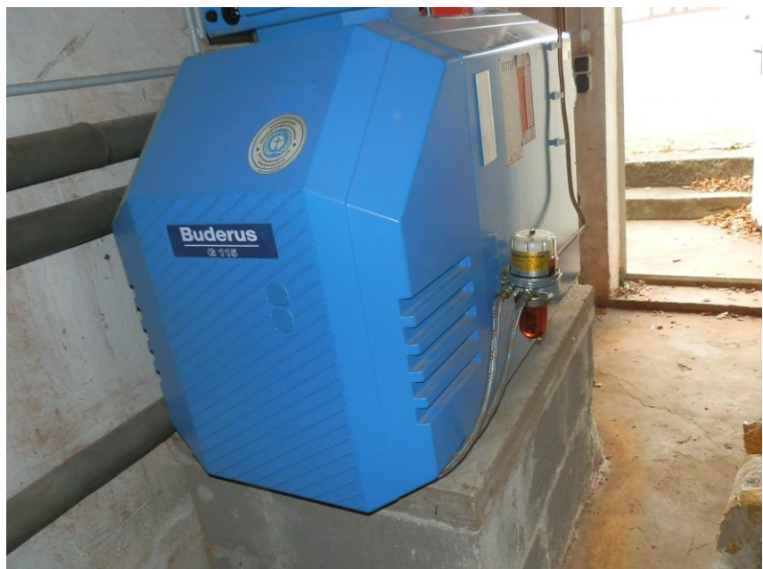
Foto: Niedertemperaturkessel
