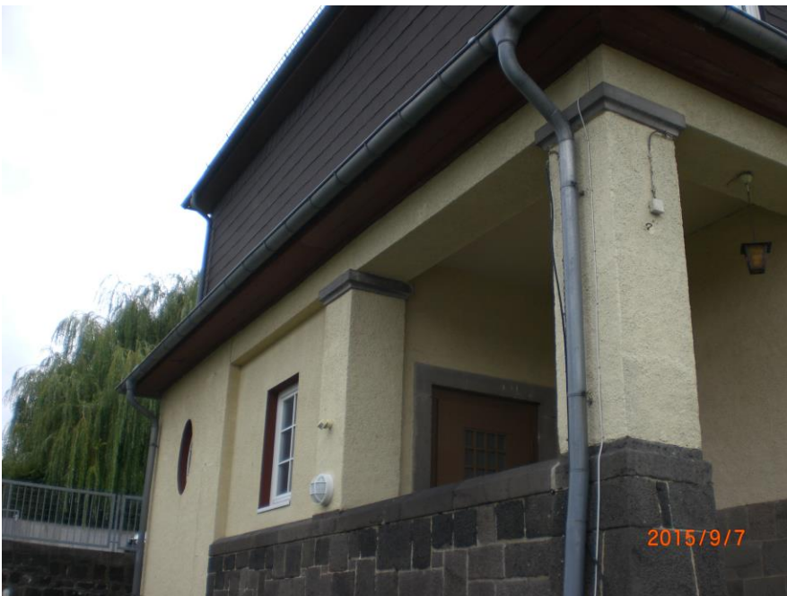
Foto: Fassade/Ansicht Süd-West
