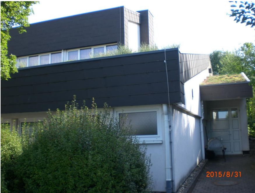
Foto: Fassade/Ansicht West
