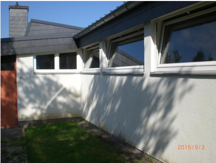
Foto: Fassade/Ansicht Süd und Ost
