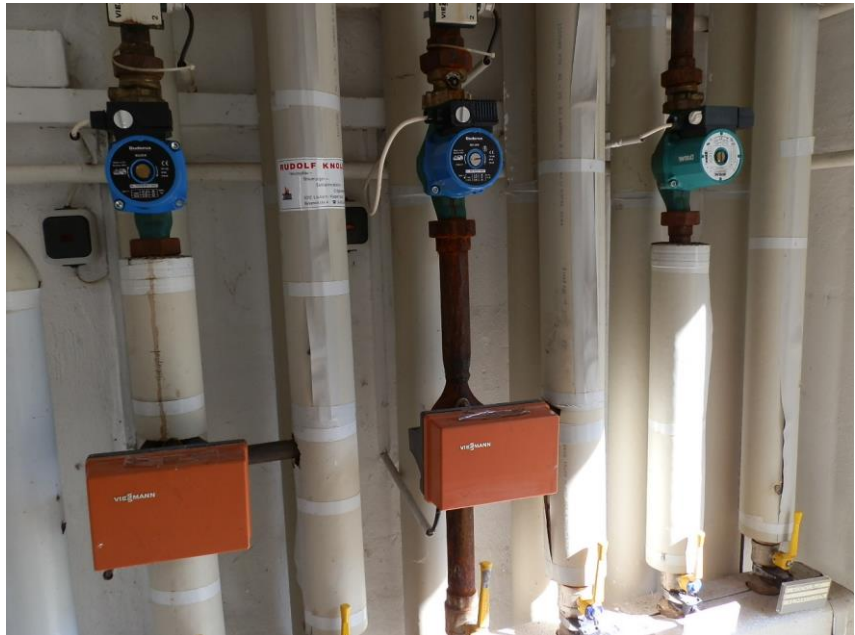
Foto: Umwälzpumpen/Verteiler
