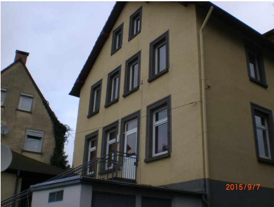
Foto: Fassade/Ansicht Süd-West
