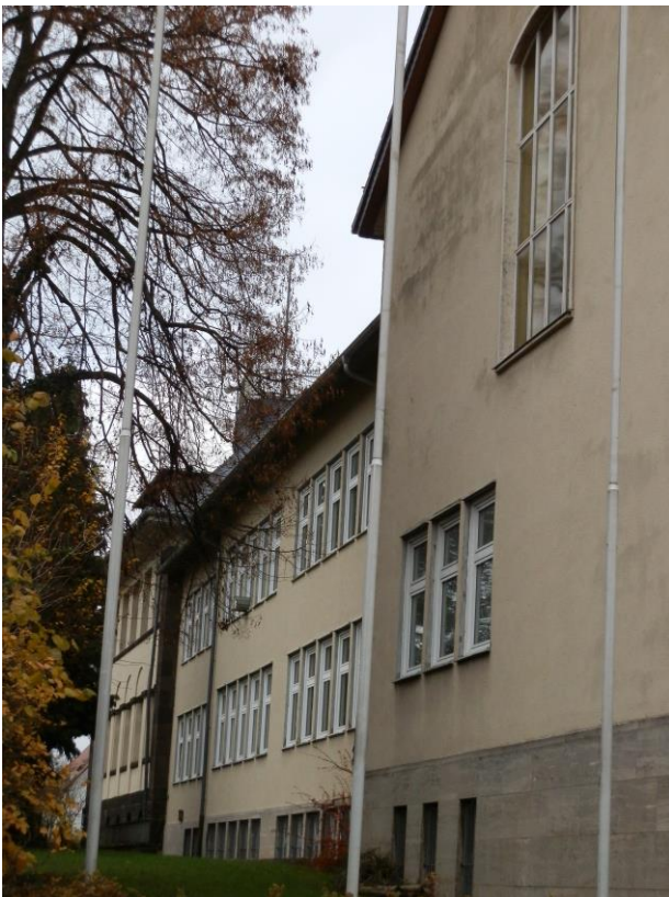
Foto: Fassade, Ansicht Süd-West
