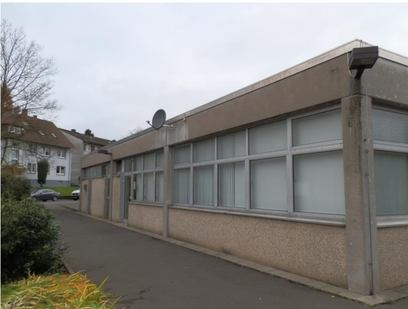
Foto: Fassade, Ansicht Süd
