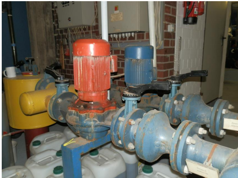
Foto: Beckenwasserumwälzpumpen
