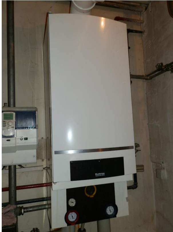
Foto: Brennwertgerät
