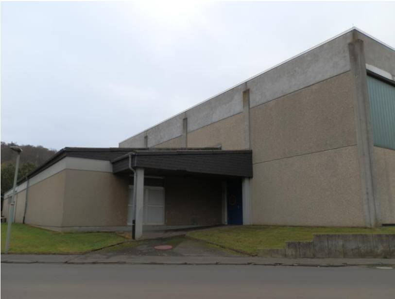
Foto: Fassade, Ansicht Nord
