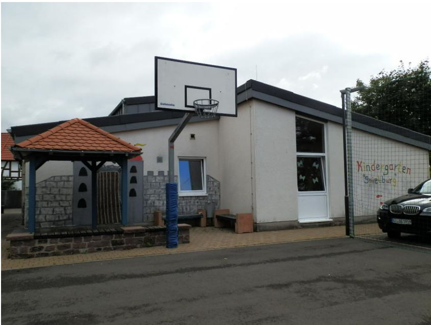
Foto: Fassade/Ansicht West
