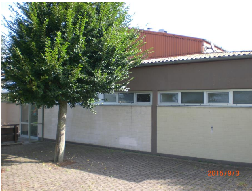
Foto: Fassade/Ansicht West
