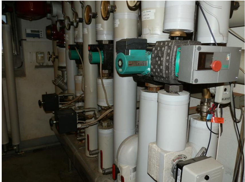
Foto: Umwälzpumpen/Verteiler
