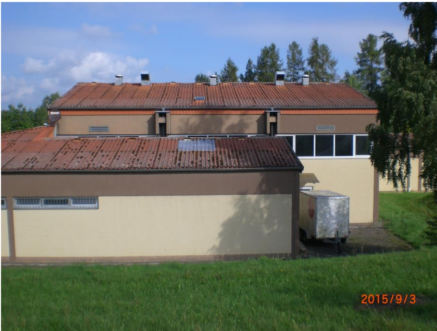
Foto: Fassade/Ansicht Süd
