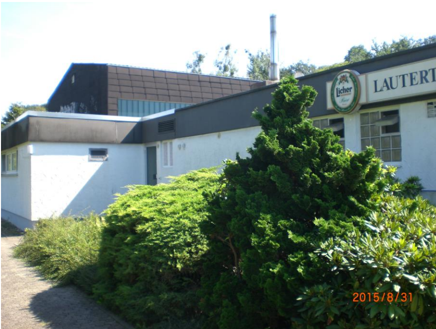
Foto: Fassade/Ansicht Nord
