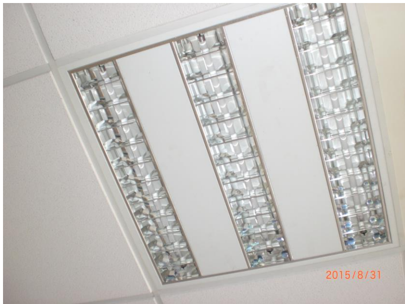
Foto: T5-Leuchtstofflampen mit elektronischen Vorschaltgeräten
