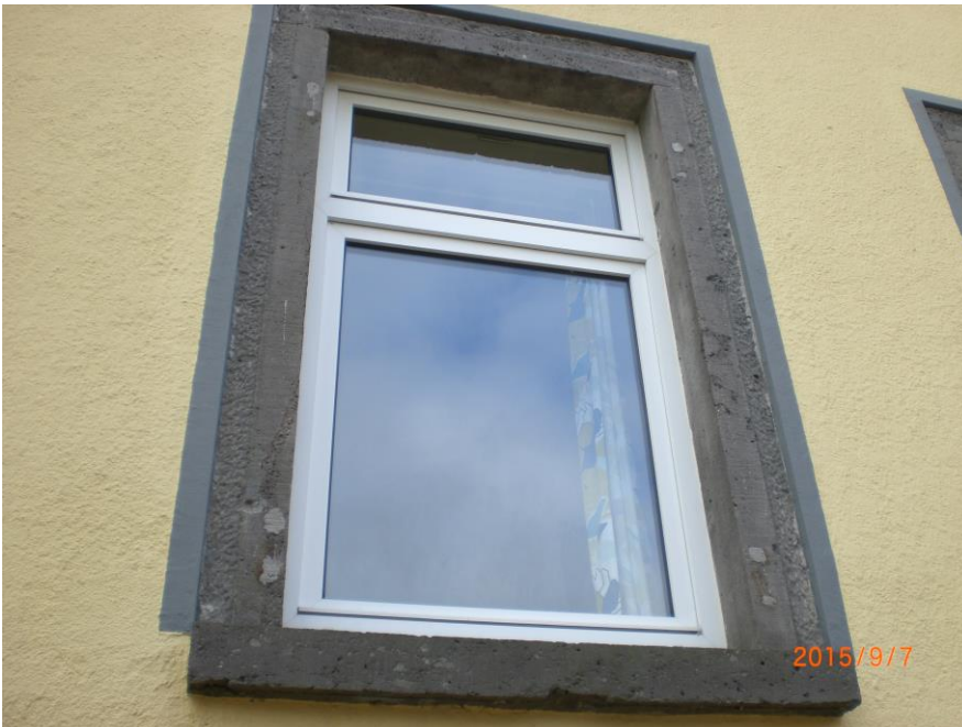
Foto: Isolierverglasung 1984
