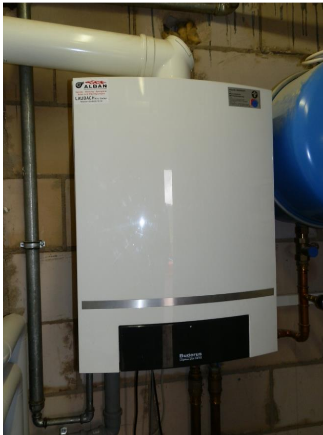
Foto: Brennwertgerät
