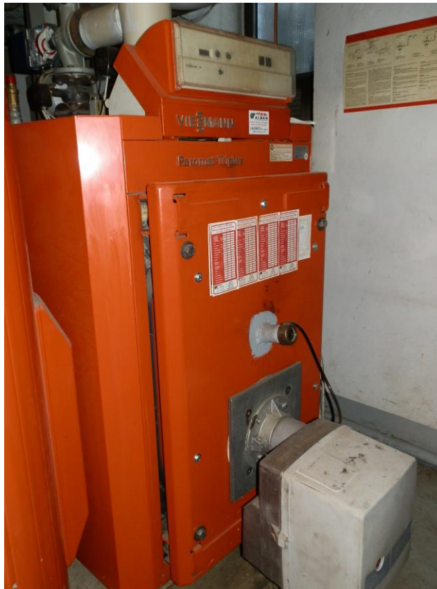
Foto: Niedertemperaturkessel
